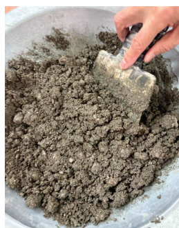
Рис. 10. Приготовление бетонной смеси
