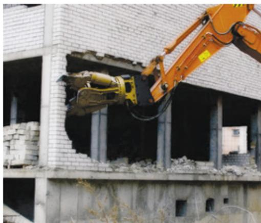
Рис. 7. Полноповоротные универсальные ножницы
