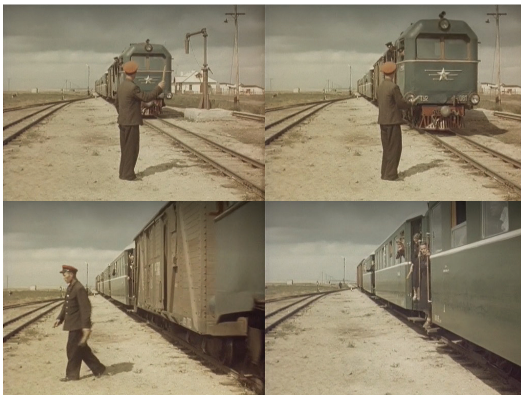
Рис. 7. Кадры из фильма «Иван Бровкин на целине», коллаж. По часовой стрелке: 1. Дежурный по станции Аниховка С. М. Корсуков встречает поезд. Видна инфраструктура дороги: песчаный балластный слой, путь на деревянном основании, гидроколонка для снабжения паровозов водой, на заднем плане слева — ручной стрелочный перевод с освещаемым стрелочным указателем, справа — жилые дома пристанционного посёлка. 2. Помощник машиниста готовится сдать жезл перегона, а дежурный по станции — принять его для возвращения в аппарат. Тепловоз ТУ2–081 крупным планом. 3. Дежурный по станции возвращается на рабочее место. Состав поезда — четырёхосный крытый вагон и четырёхосные цельнометаллические вагоны Rafawag 3aW. 4. Поездная бригада готовится к высадке пассажиров. На заднем плане: дежурный стрелочного поста возвращается с места встречи поезда для закрытия входного семафора
