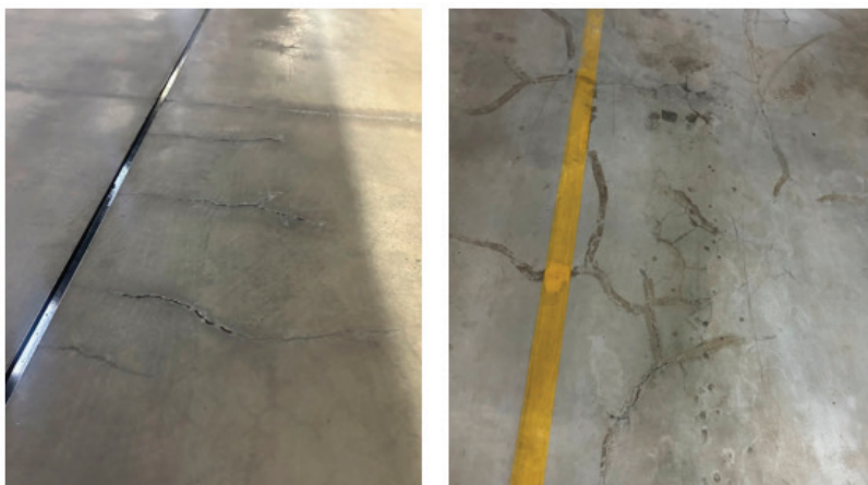
Рис. 1. Трещины в паркинге
