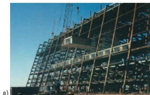
Рис. 3. Конструктивные схемы модульных зданий: а) из составленных модулей, б) с ядром жесткости, в) с внешним стальным каркасом
