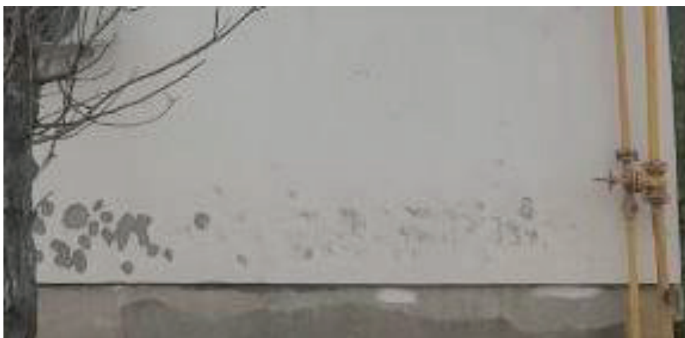
Рис. 5. Механическое повреждение теплоизоляционного слоя без наружного защитного слоя в следствие ударов града
