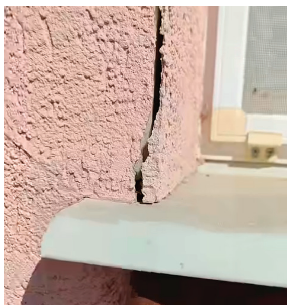
Рис. 4. Несоответствие качества армирующей сетки
