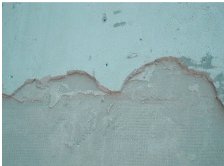
Рис. 1. Отсутствие крепежного элемента теплоизоляционного слоя
