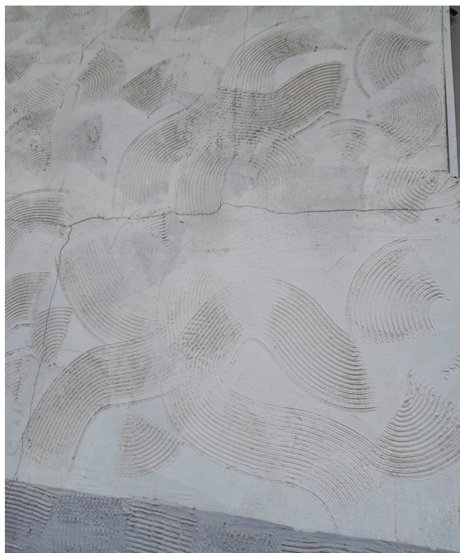
Рис. 8. Образование трещин в теплоизоляционной штукатурке
