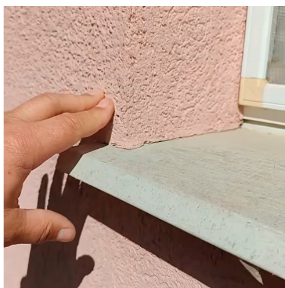
Рис. 3. Нарушение технологии примыкая недостаточная защита от влаги
